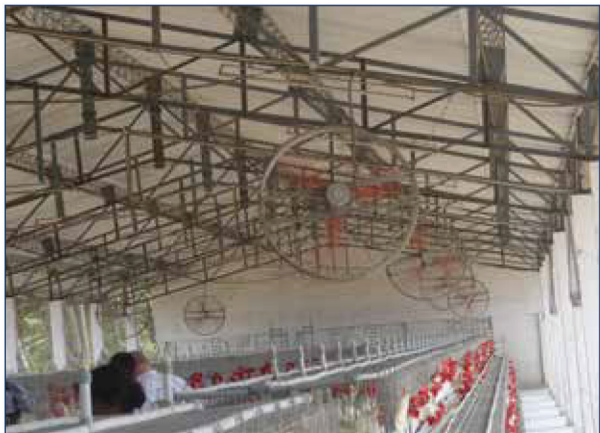
పటము 1. ఫాన్లు, ఫాగర్లు పనిచేసినప్పుడు షెడ్డు లోపల గాలి కదిలే వేగము పెరిగి, షెడ్డు కొంత చల్లబడుతుంది.
