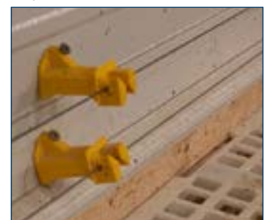
Figura 11. Alambres eléctricos disuasivos colocados en el perímetro de las paredes de la instalación.
