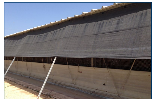
Gambar 9. Tirai jendela berpori menghalangi sinar matahari langsung memasuki kandang, tetapi membiarkan udara masuk.
