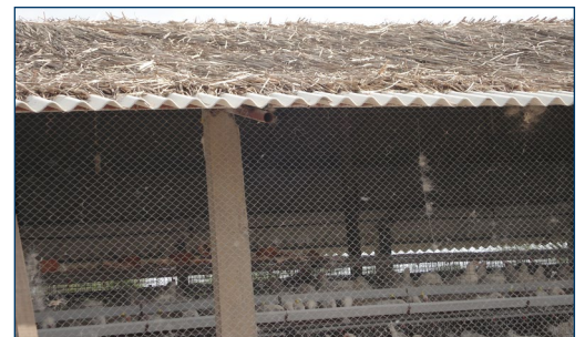
Gambar 8. Penggunaan material rumbia (jerami padi, batang jagung, pucuk tebu) untuk mengurangi panas matahari pada atap.
