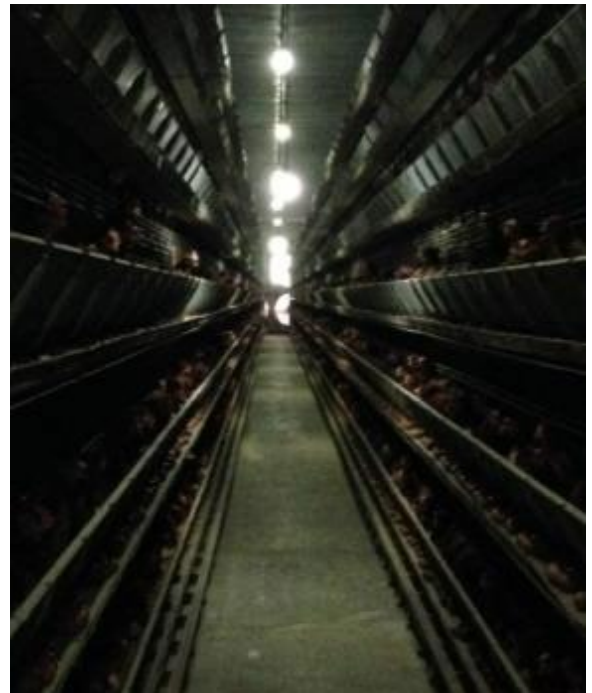
Figure 18. Les lumières LED installées dans ce bâtiment sont trop directionnelles, trop espacées et pas assez lumineuses. La combinaison de ces facteurs entraîne des ombres évidentes sur le sol et une mauvaise uniformité de la lumière le long des cages.
